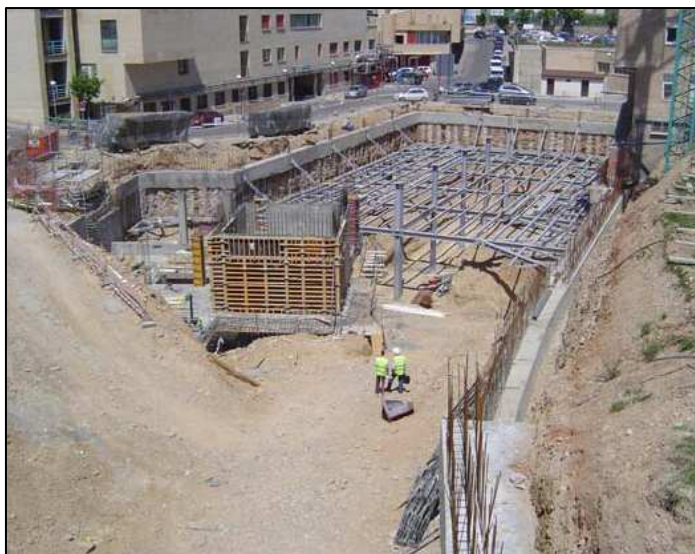
Estructura metálica de acodamiento y núcleo central
