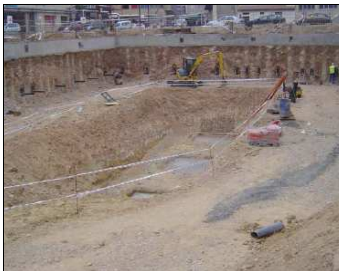
Trabajos de excavación y cimentación
