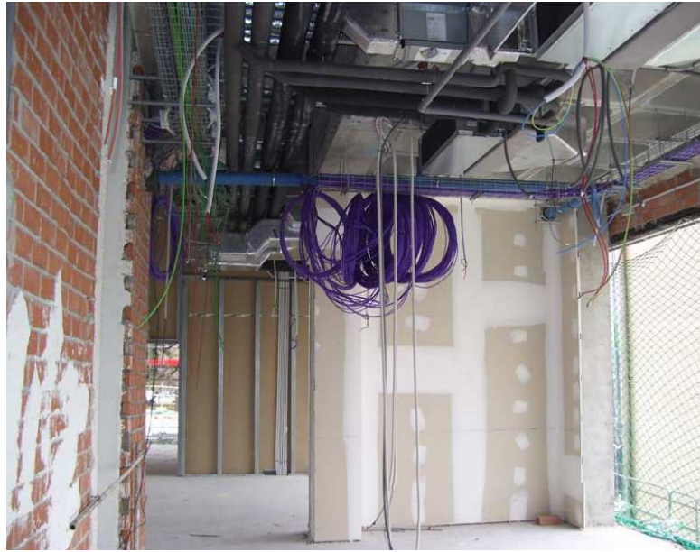
Cerramientos e instalaciones interiores
