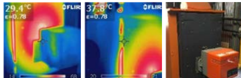
Termografías realizadas a las calderas del CIBA en la auditoría energética realizada en 2019
